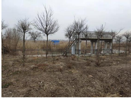
图 1-8 东湖外海节制闸
